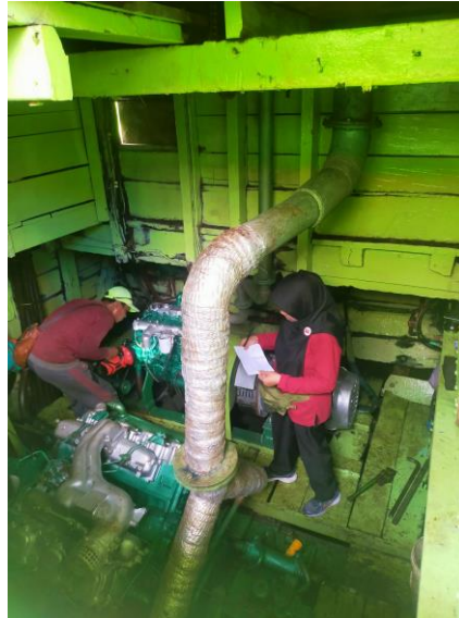
Gambar 8. Ruang Mesin Kapal Penangkap Ikan
